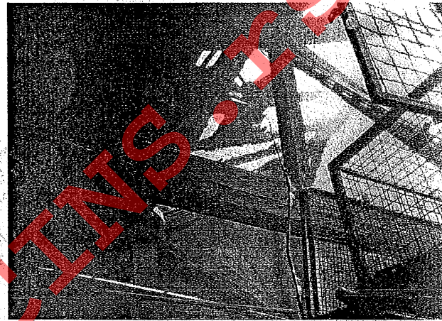
Фот. 16 Мањи степен термичке деградације дрвене греде, лево од улаа
