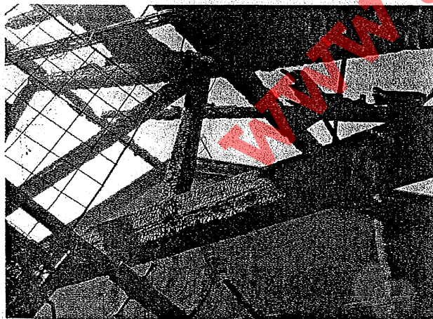
Фот. 17 Већи степен термичке деградације дрвене греде, десно од улаа
